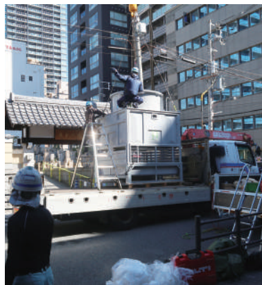
クレーンによって運びこまれ る新しい空調機
